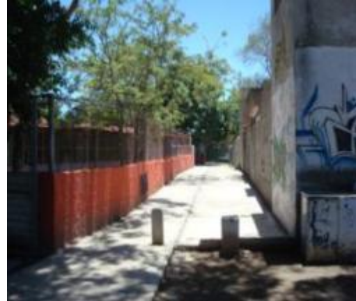
Fig. 6. Área deteriorada junto al Kinder. sobre el andador "Casa del obrero mundial"
