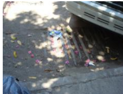
Fig. 7 Rejilla de desagüe en andador rio blanco
