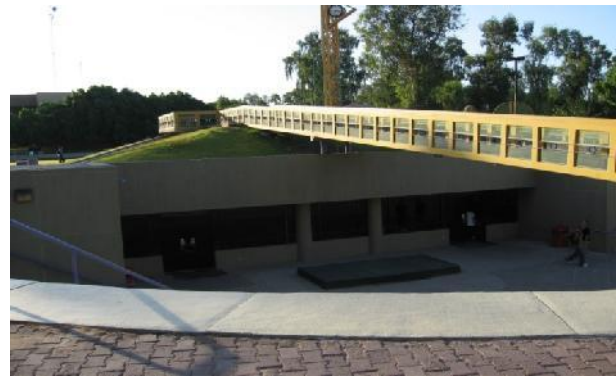
Fig. 2 Construcción Subterránea (UABC Campus Mexicali Unidad de Servicios Estudiantiles).
