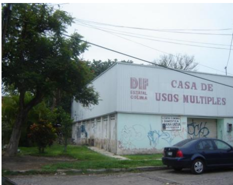
Fig.12. Casa de usos múltiples, en abandono. (2011)
