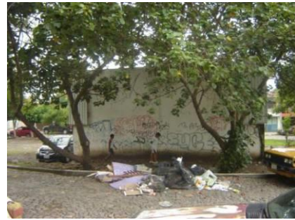
Fig.13. Casa de usos múltiples, en abandono. Vista hacia la unidad médica familiar 16. (Foto del 2011)
